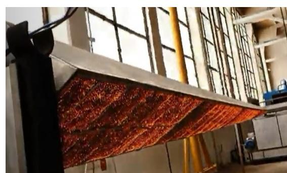
Modulație - adaptarea puterii arzătorului la necesarul de căldură
